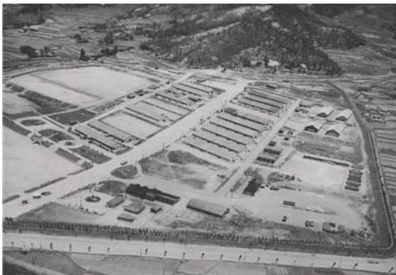
진해 공사 전경(1952)
