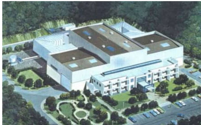
공사 풍동과 연구동 모습
